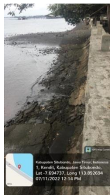
Gambar 8. Bangunan Pelindung Pantai Titik U
