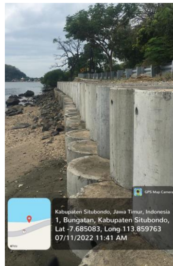
Gambar 6. Bangunan Pelindung Pantai Titik O
