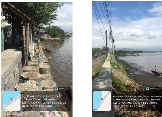
Gambar 3 dan 4. Bangunan Pelindung Pantai Titik H, a). barat, b). timur
