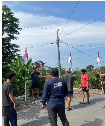
Gambar 2. Pemasangan Kaca Cembung
