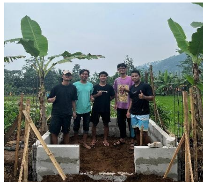
Gambar 1. Pembangunan Tempat Pembuangan Sampah (TPS) Permanen
