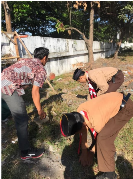
Gambar 1. Pembersihan Lokasi Pembangunan Instalasi
