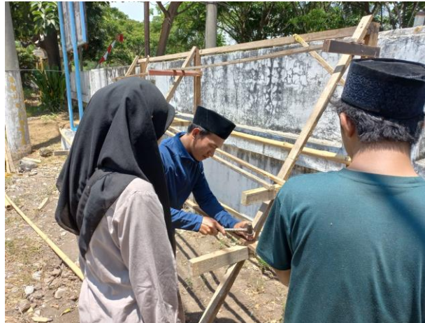
Gambar 2. Pembangunan Instalasi NFT
