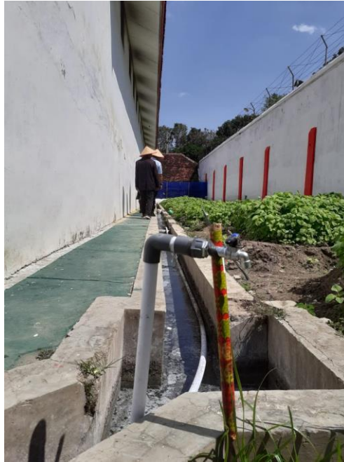
Gambar 2. Keadaan kebun setelah dibangun instalasi irigasi mengambil air dari saluran pipa air bersih
