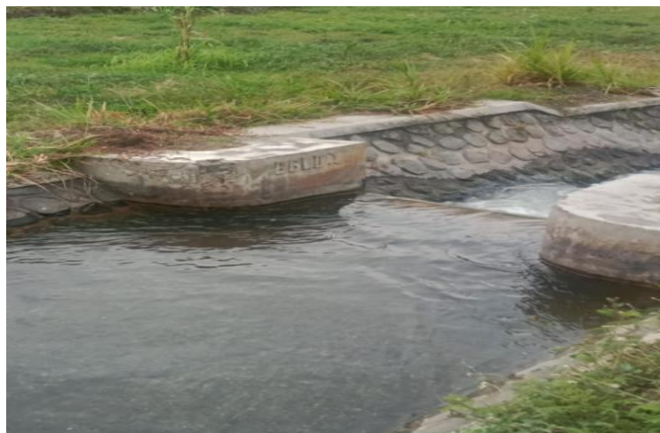
Gambar 2. Bangunan Ukur Ambang Lebar ( Drempele ) Sungai Bluncong
