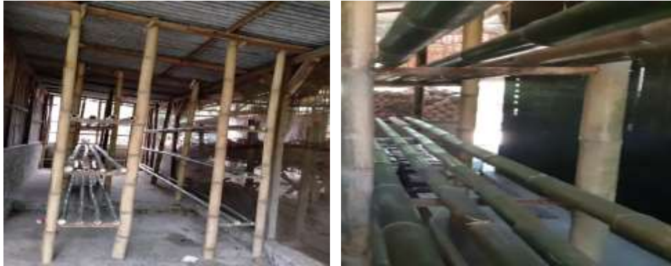
Gambar 7. Rak susun yang terbuat dari bambu yang didistribusikan kepada pemuda dan wanita tani
