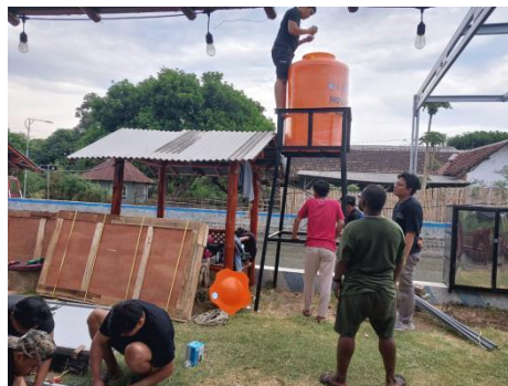
Gambar 6. Pemasangan filter air
