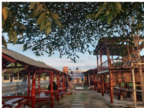
Gambar 4. Kondisi WIKAS setelah pemasangan PLTS Hybrid
