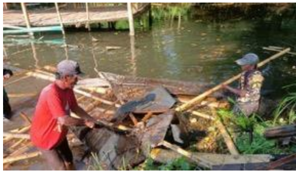
Gambar 5. Pengangkatan Bambu yang Sudah Lapuk
