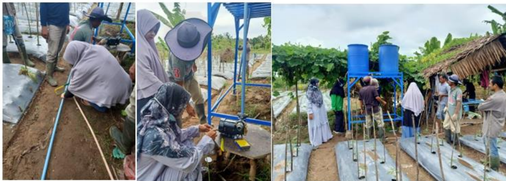
Gambar 7. Proses instalasi tangki penampungan air
