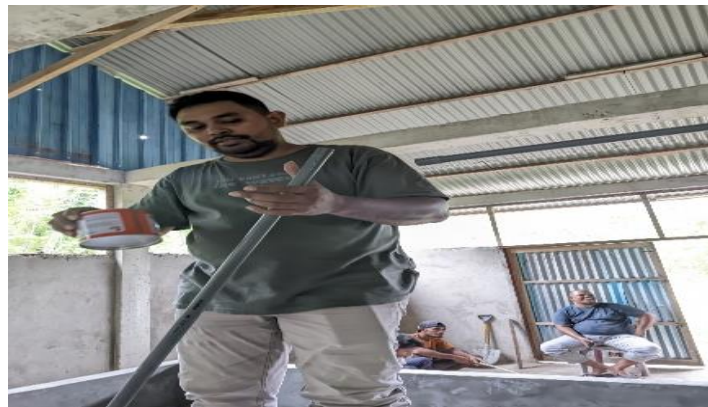
Gambar 5. Pemasangan Pipa Untuk Instalasi Aerasi Pada Bak-Bak Hatchery
